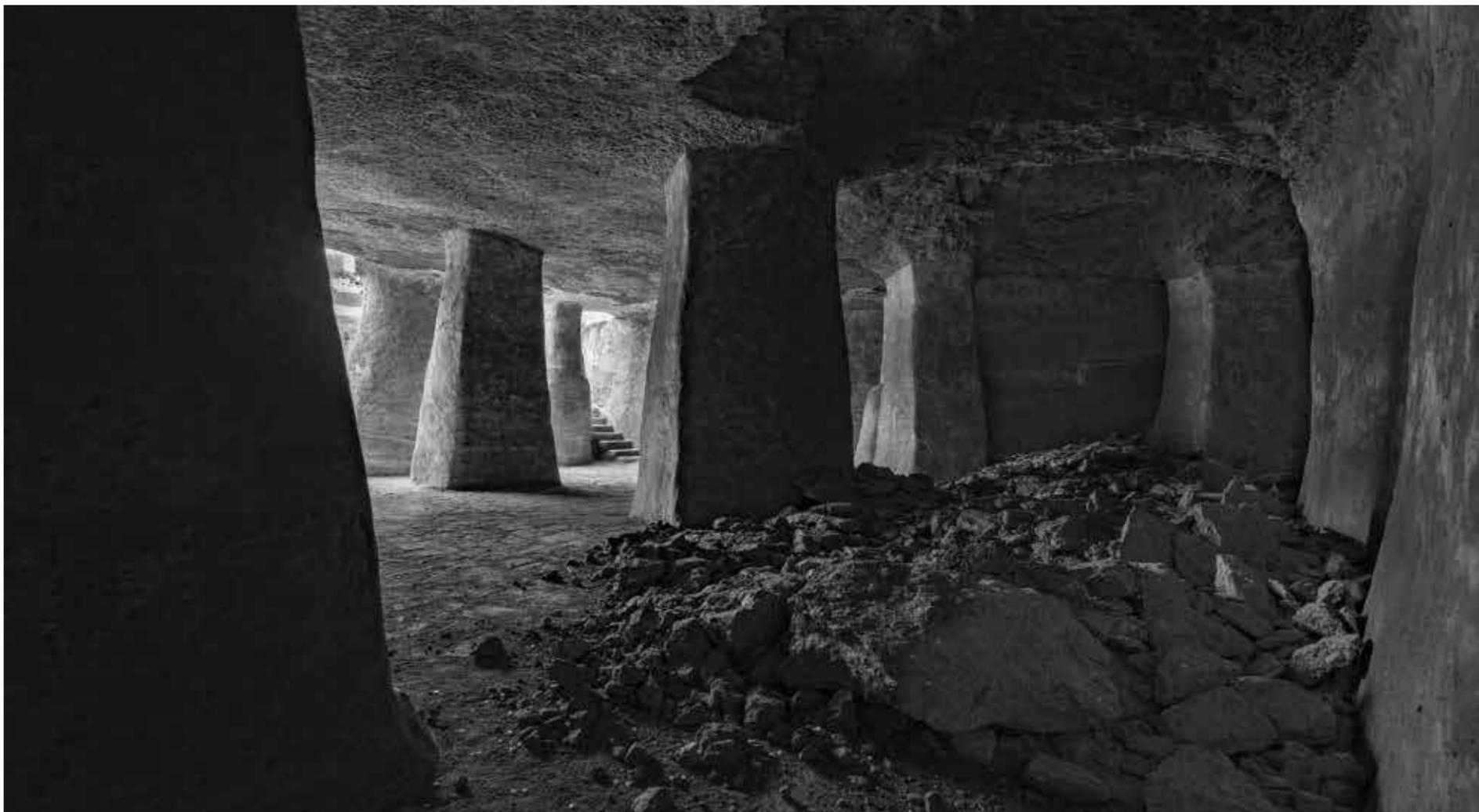
Tanque cueva (estanque subterráneo excavado en la toba) abandonado y con muestras de derrumbes en la finca San Rafael, en Telde. | TATO GONÇALVES
